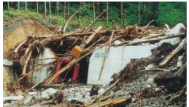
土石流、流木を捕捉した砂防堰堤 (日田市上津江町)
