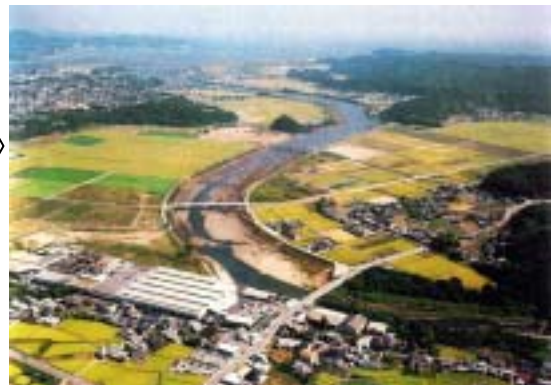
改修後：川幅を3～4倍に拡幅（平成13年撮影）
