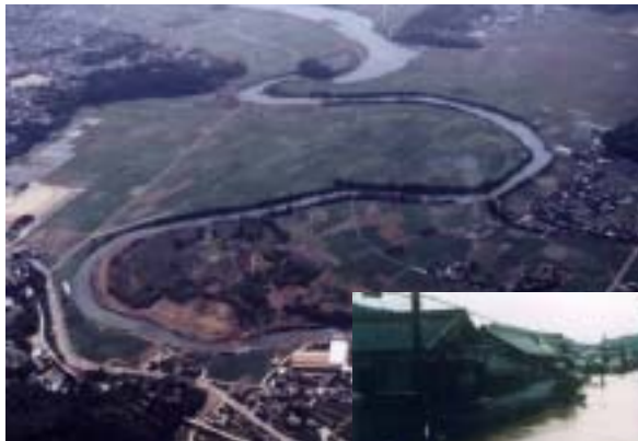
改修前（平成7年撮影）
