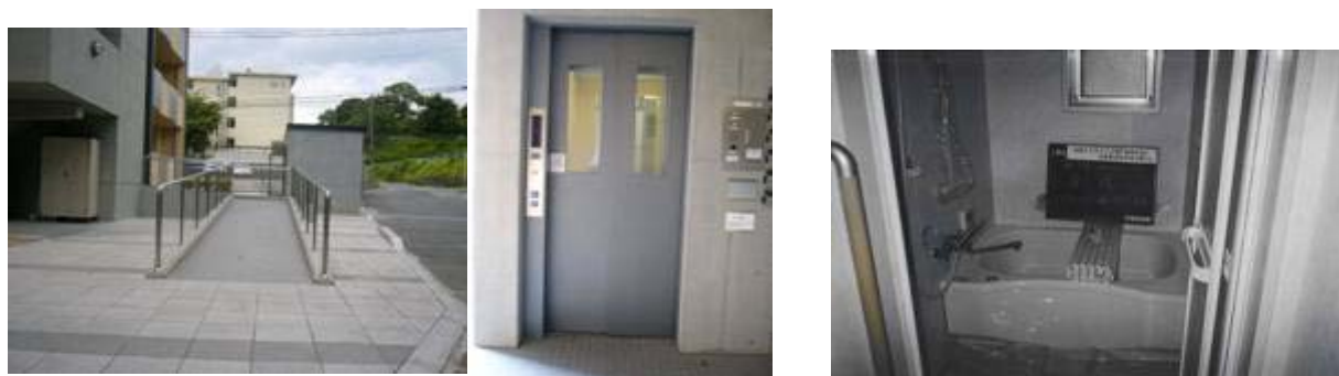
エレベータ等を整備し、バリアフリー化した住宅 既存県営住宅高齢者対応改修 施工例 またぎ高さを低くして使いやすくした浴槽
