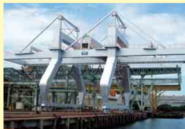
20t×16mスパン橋型クレーン
