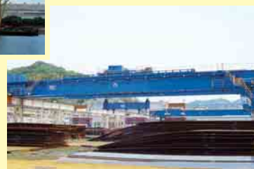
30 t×28mリフマグ付天井クレーン
