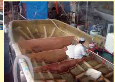
隔壁取り付け作業
