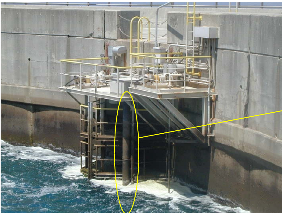
伊方1, 2号機放水口水モニタ設置状況
