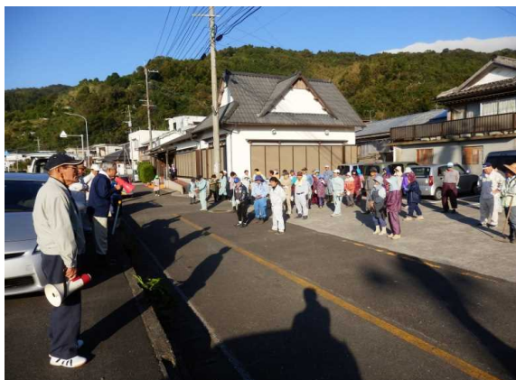
作業前のあいさつ、作業内容の確認
