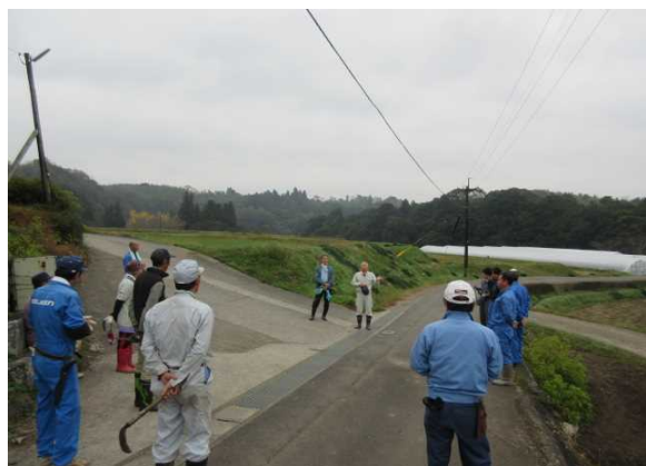
作業前のあいさつ、作業内容確認
