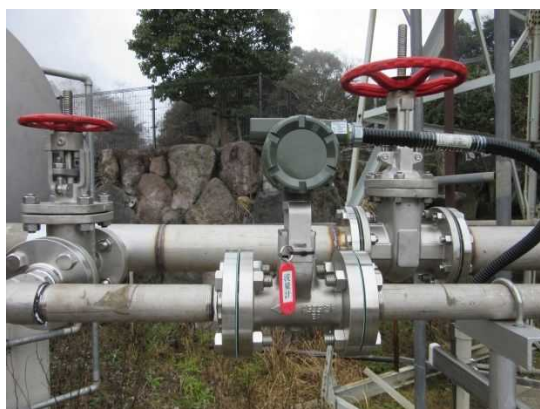
泉源に設置した流量計
