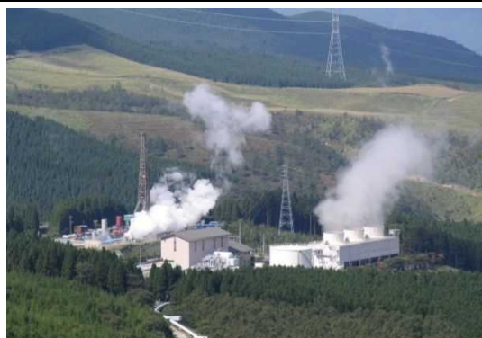
滝上発電所での噴出試験 （提供：出光大分地熱株式会社）
