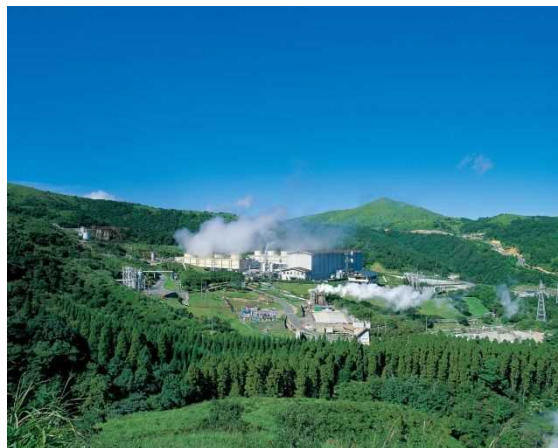
九州電力八丁原発電所 （提供：九州電力株式会社）
