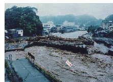
平成2年7月出水の状況 (稲葉川 豊岡橋付近)
