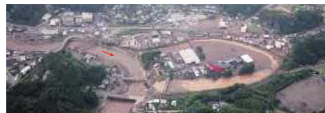
平成24年7月出水の状況 (玉来川 竹田市文化会館付近)
