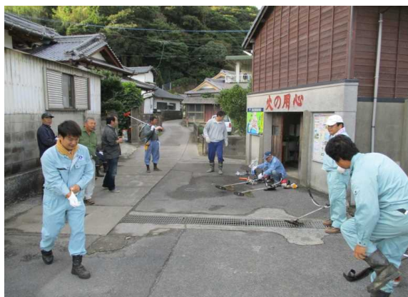
作業前のあいさつ、作業内容確認
