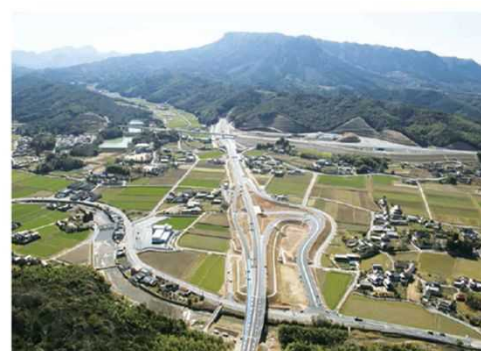
日田に向かって整備が進む中津日田道路
