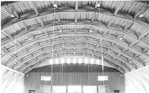
体育館の内部から見たスギ丸太トラスアーチ
