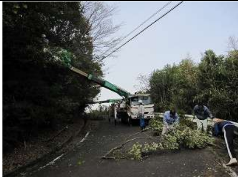
高所作業車で枝打ち作業
