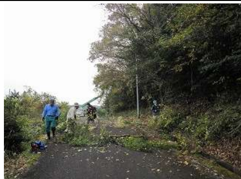
まちづくり協議会と地元集落民が片付け作業
