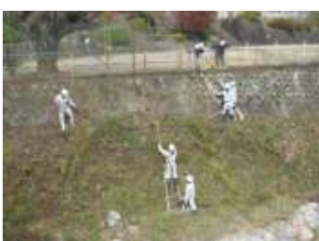
(足場の悪い急斜面での作業)
