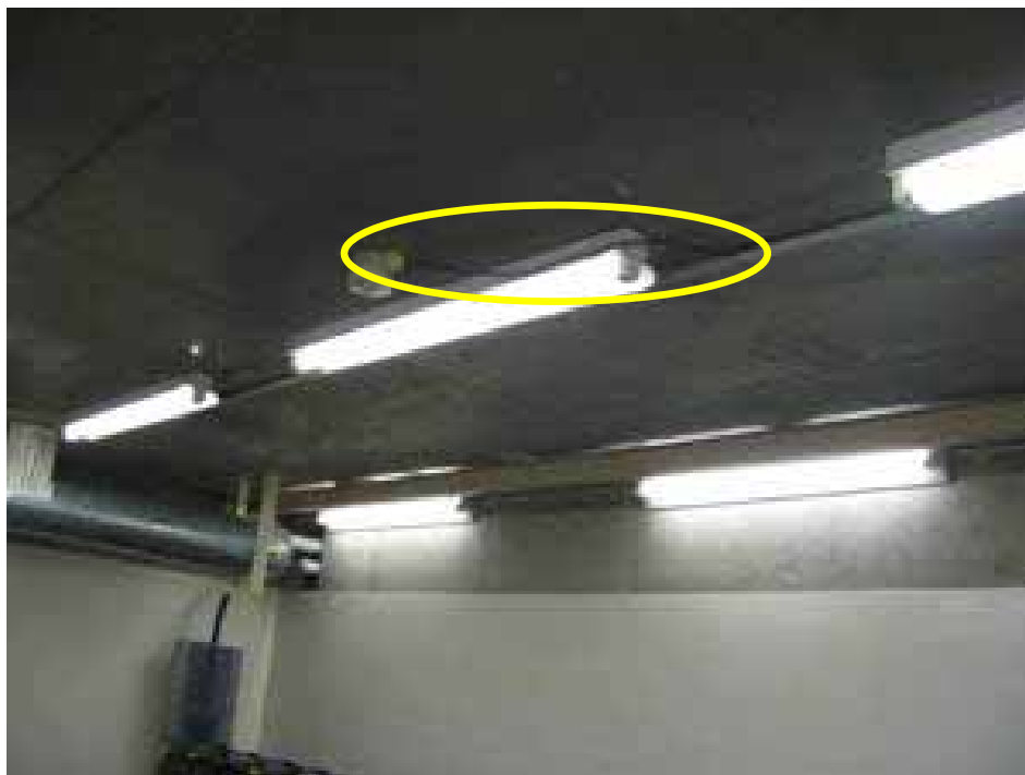
感知器：蓄電池室 3 A
