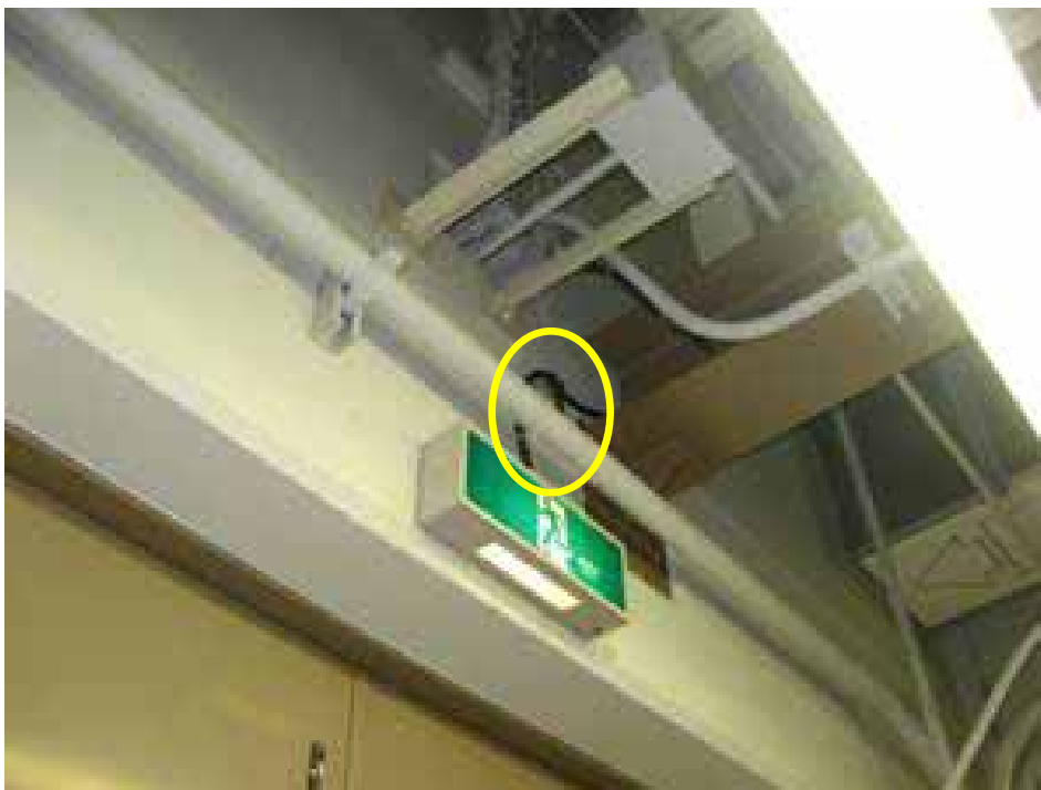
誘導灯：インバータ室 3 A
