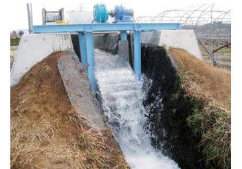
地場企業によるマイクロ水力発電システムの実証機（日田市）
