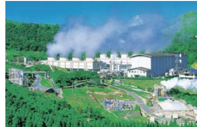
日本一の発電量を誇る八丁原地熱発電所
