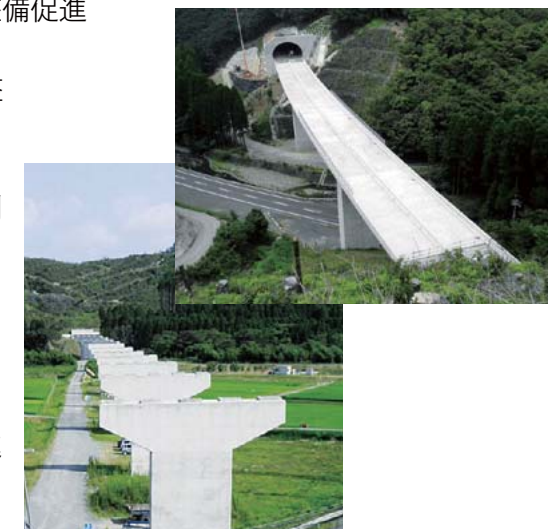
着実に工事が進む東九州自動車道 (佐伯市)
