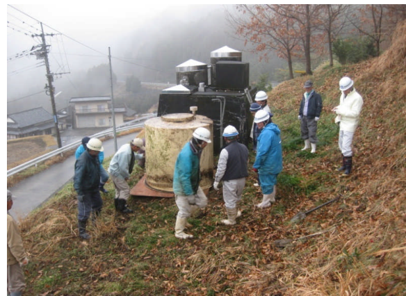
仮設タンクの設置終了
