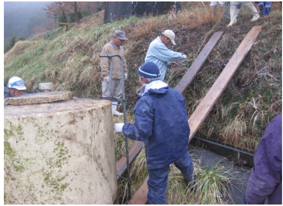
仮設タンクの移動
