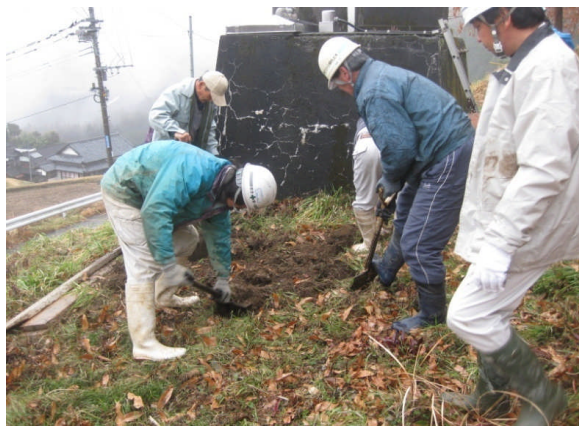
貯水槽横の仮設タンク設置場所を地ならし
