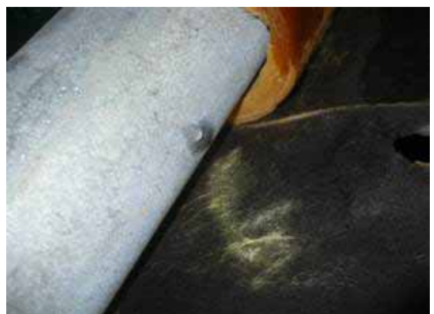
配管ピンホール
