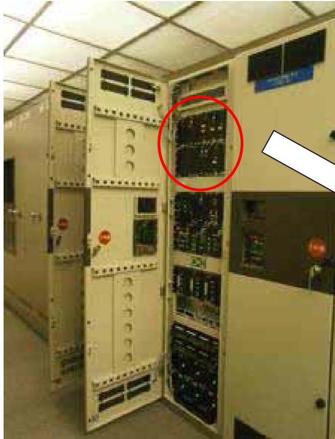
炉外核計装盤 1 号
