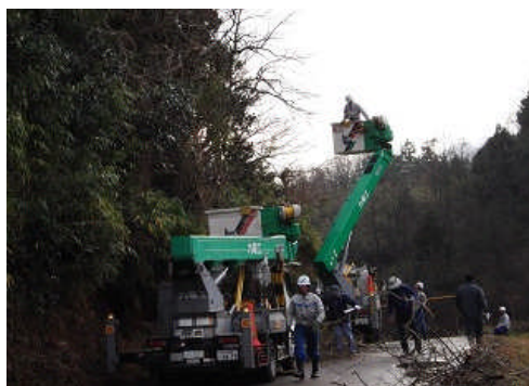
九電工高所作業車5台で枝打ち作業
