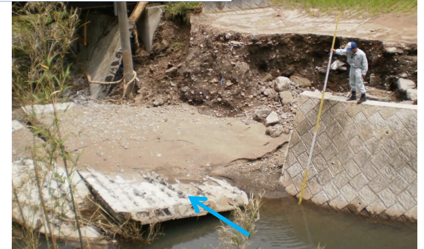
③ 河川護岸流失状況 (既設石積みが流失)
