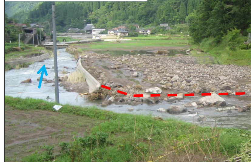
② 河川護岸埋塞状況 (田面と同じ高さまで堆積)
