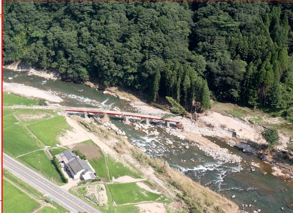
② 第四山国川橋
