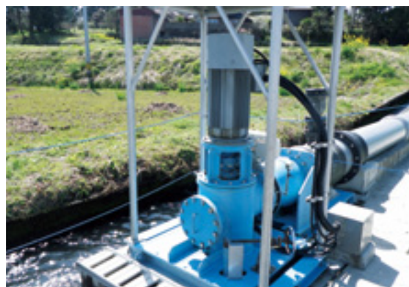
竹田市城原地区水力発電所に完成した水力発電装置。少ない水量でも効率よく発電量を増やすことができ、余剰電気は電力会社に売電できる。
