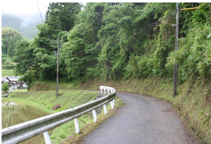
作業後の集落道1
