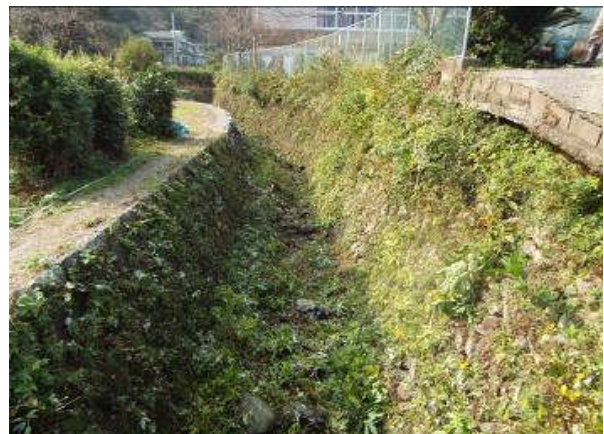
作業終了後(河川)
