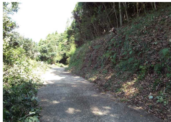
木伐採作業後
