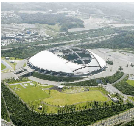
スポーツの中核施設となる大分スポーツ公園
