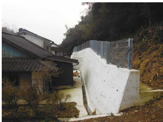
人家を守る急傾斜地崩壊防止施設
