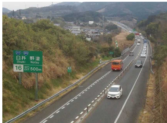
4 車線化に取り組む東九州自動車道
