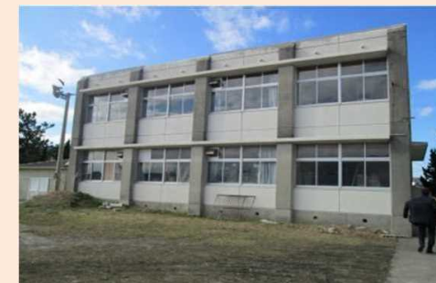
改修中の旧校舎
