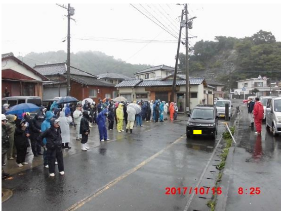
作業前のあいさつ、作業内容の確認
