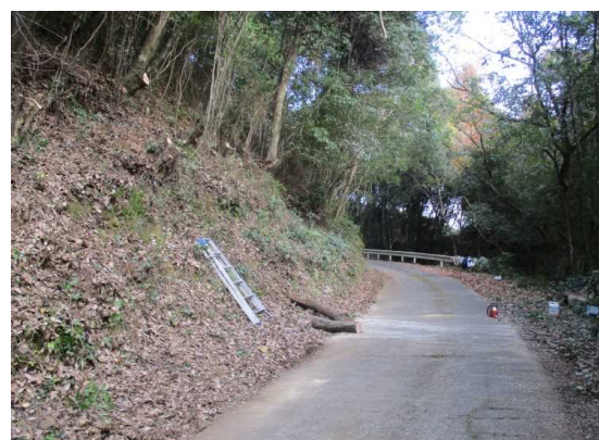
木伐採作業後
