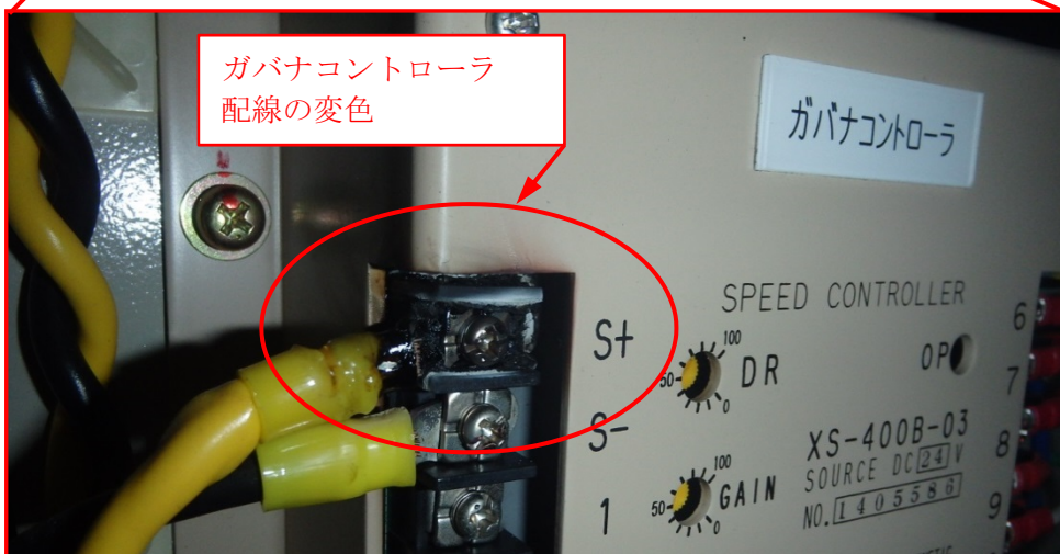
300kVA 電源車 今回事象発生時の状況
