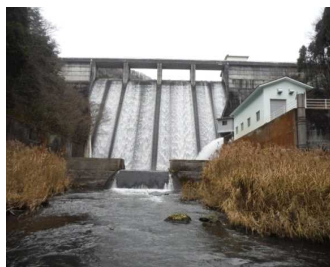
松木ダム発電所
