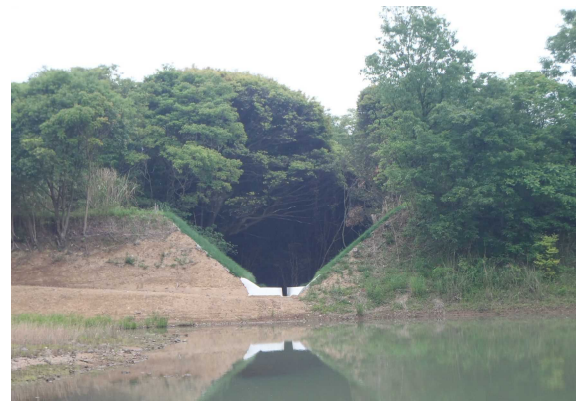
廃止工事が完成した国東市「新池」地区
