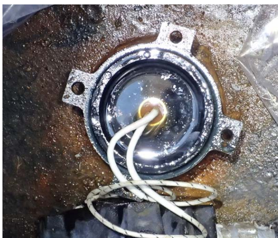
補助ボイラ燃料タンク熱感知器端子箱内部 浸水時状況
