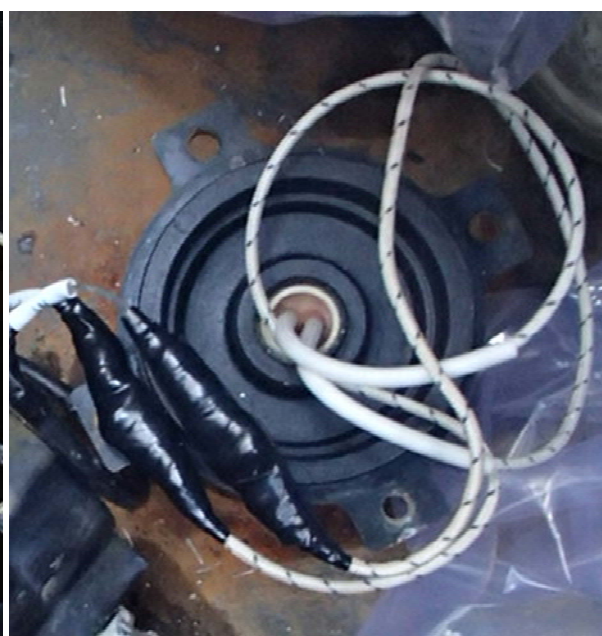
補助ボイラ燃料タンク熱感知器端子箱内部 結線部の状況（手入れ後）
