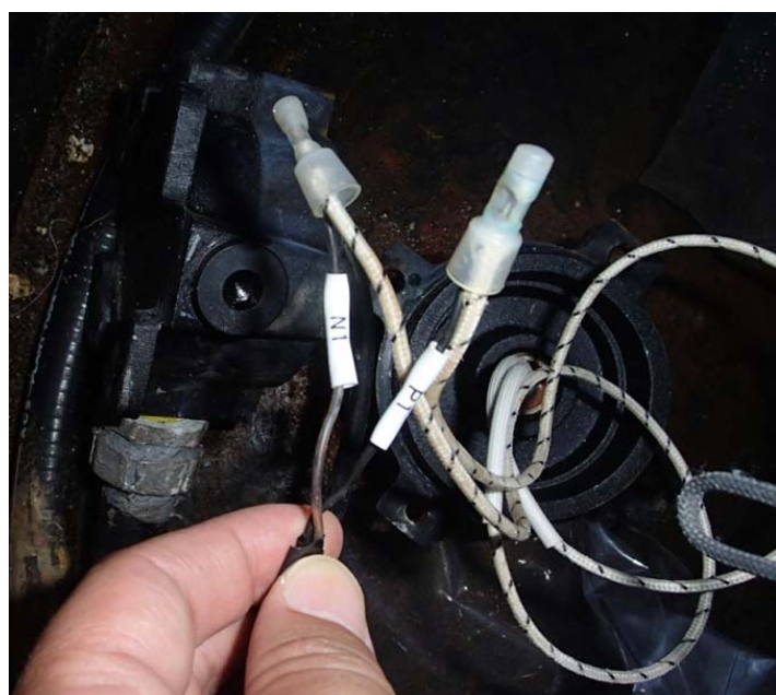
補助ボイラ燃料タンク熱感知器端子箱内部 結線部の状況（手入れ前）
