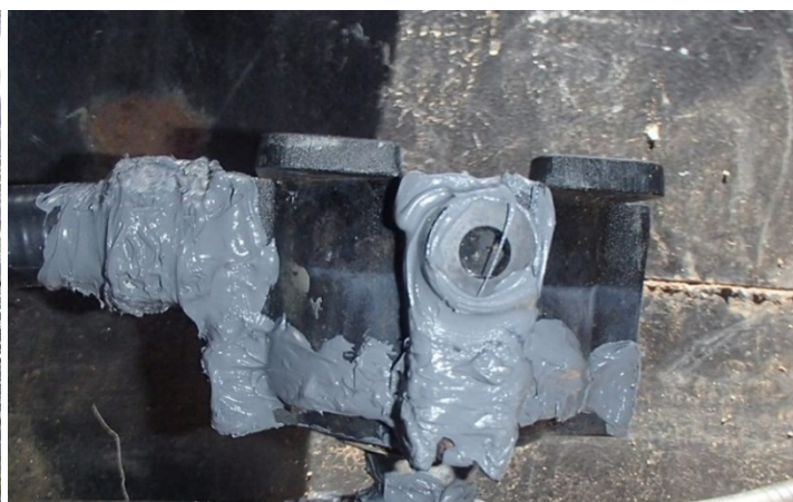
補助ボイラ燃料タンク熱感知器端子箱 防水処理状況
