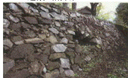
石垣 (南台北側)
