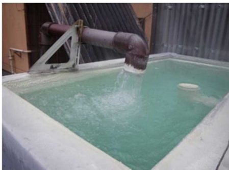
図2 落下式ばっ気槽
