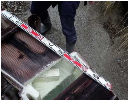
図 8 樋の中に設置されたレンガ
