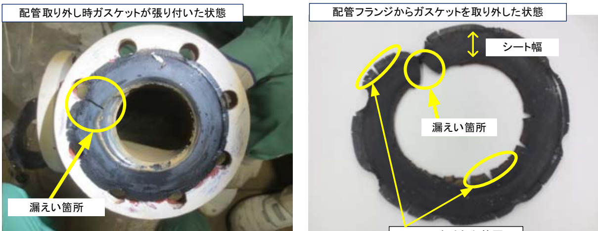
ガスケット点検状況
