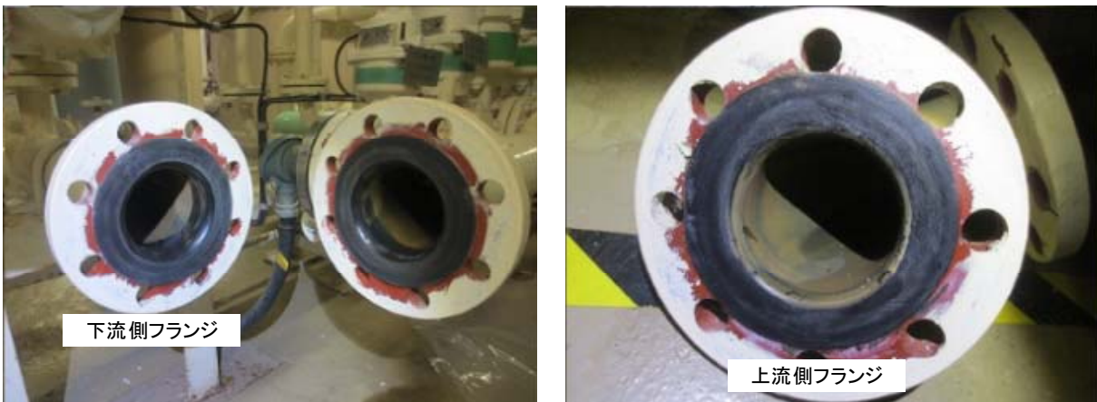
フランジ部外観目視点検状況
