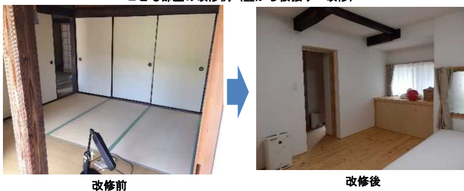
こども部屋の改修例（畳から板張りへ改修）
