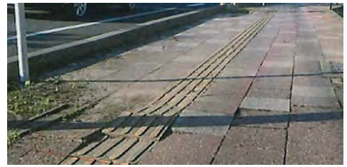
損傷が激しい歩道 (国道213号：国東市鶴川)
