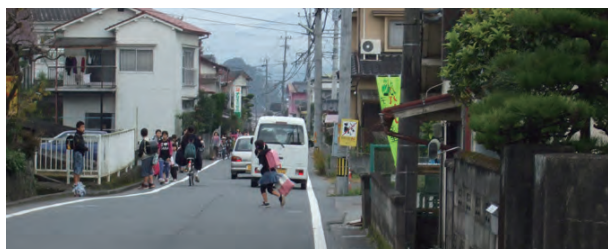
自歩道等の新設が必要な街路((都)銭淵大宮線:日田市)
