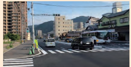
(都)山田関の江線(西野口町工区：別府市)
