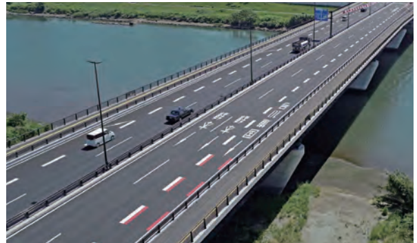
交通渋滞解消など交通円滑化に資する橋梁の建設（宗麟大橋）
