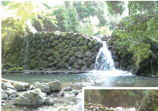
水通し部が欠損
