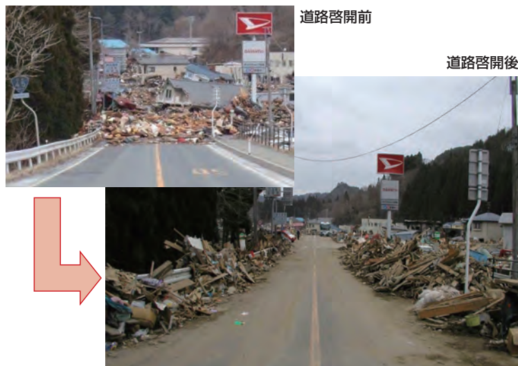
救命・救急、復旧活動に向け迅速な道路啓開が必要
