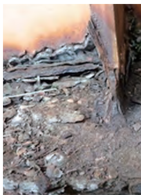
主桁の紡織機能の劣化・腐食
