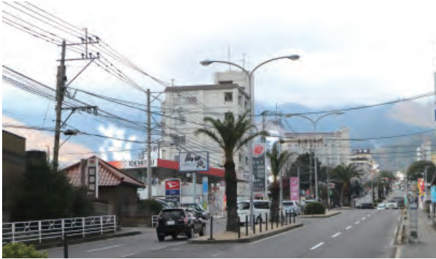
景観を損なう電線や電柱
