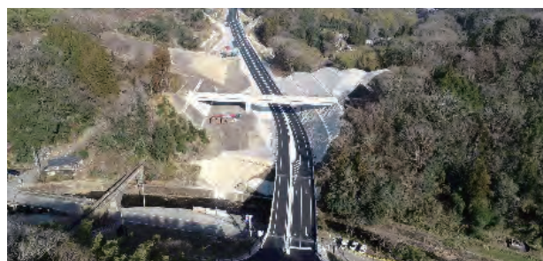
整備が進む中九州横断道路(竹田ICから犬飼方面を望む)
