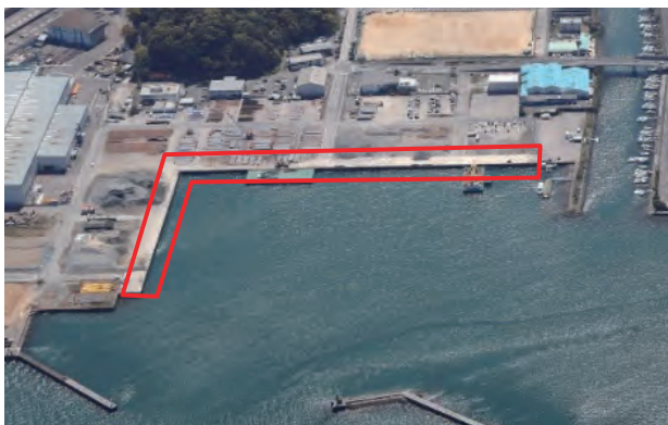
早期対策が必要な岸壁（佐伯港（鶴谷地区））
