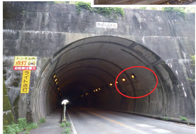
国道213号 権現トンネル（国東市）
