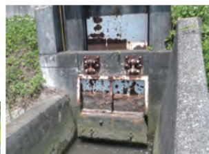
鋼製の扉の腐食が進行
