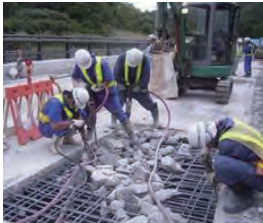
橋梁補修状況
