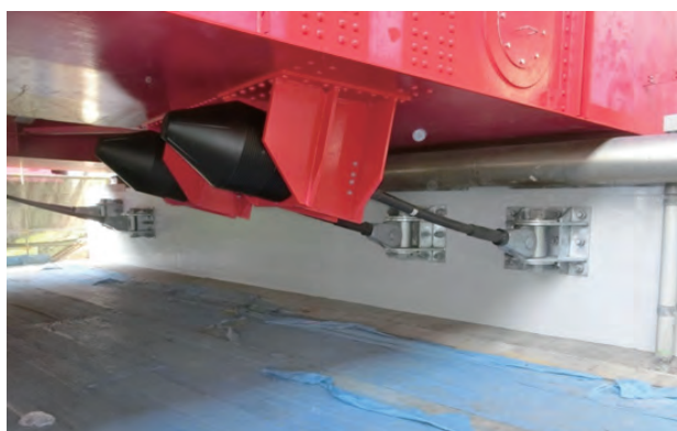
着実な橋梁耐震化の推進 (大在大分港線 大在大橋)
