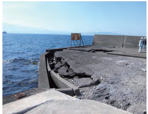
護岸の劣化状況
