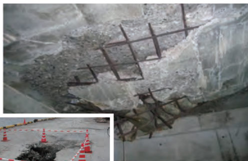
床版の劣化状況
