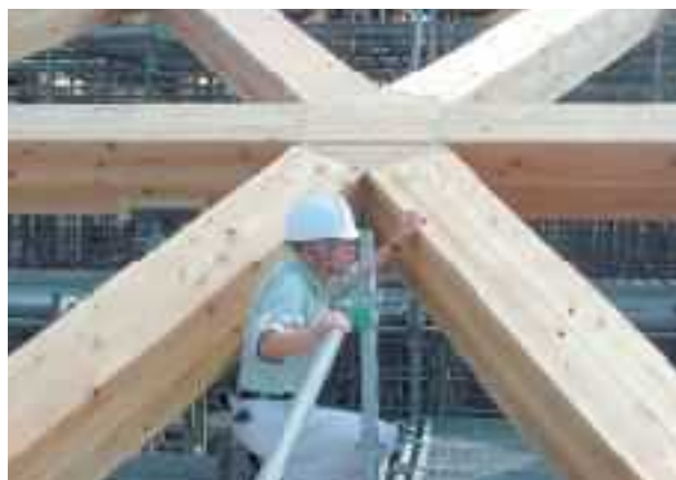
接合部（エポキシ樹脂注入）
