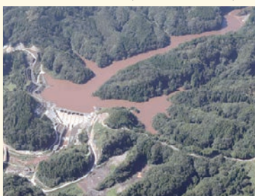
台風14号による大雨で満水となった玉来ダム (9月20日撮影)
