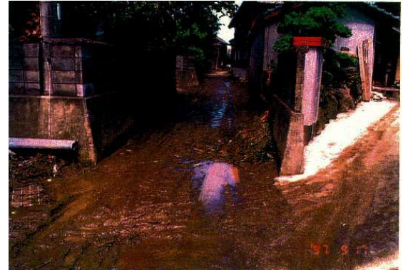
写真 2. 1. 6 安岐川右岸(沢掛地区)の浸水状況 【平成 9 年 9 月洪水】
