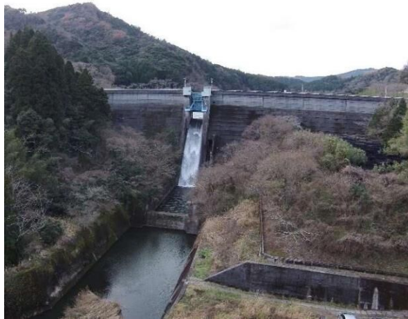
写真 2.2.1 安岐ダム (国東市安岐町矢川)
