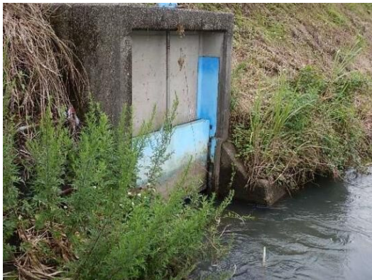
写真 2.1.7 老朽化した樋管
