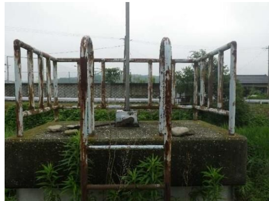
写真 2.1.7 老朽化した樋管
