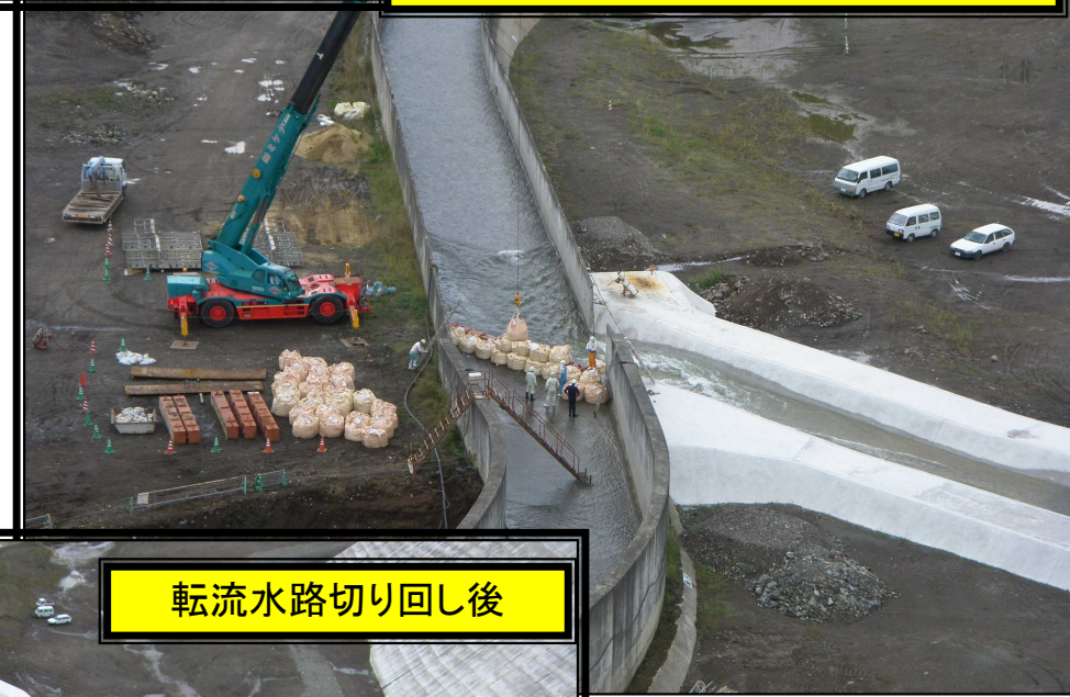
10月9日 転流水路切り回し作業
