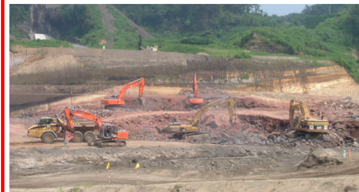
引き続き掘削工事を続行中です
