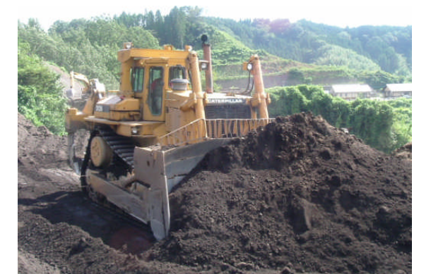
掘削に使うブルドーザーです
