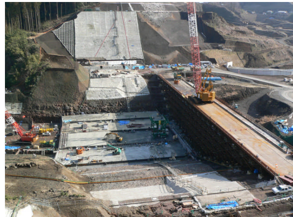
300tonクレーンと4.5m 3 バケットを使用して
