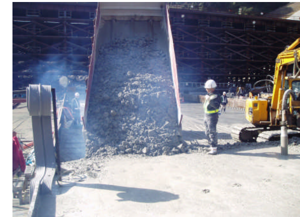
積み替えた10tonダンプトラックでダム本体内を運搬し、
