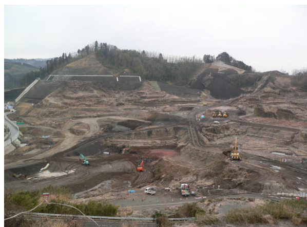
貯水池対策工事
