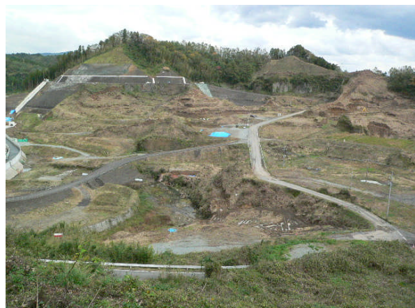
貯水池対策工事 撮影日：平成16年10月30日(伐採後)
