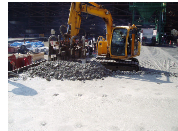
荷卸されたコンクリートは、締固め機械(バイバック)により念入り
