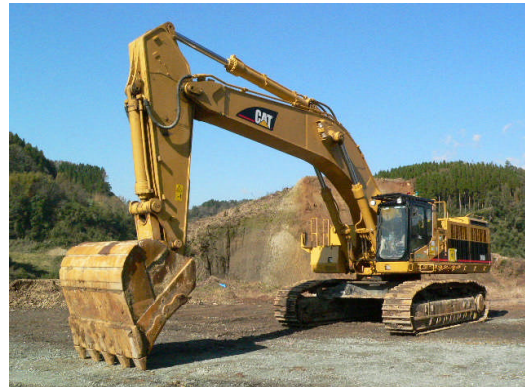
貯水池内を掘削する油圧ショベル
