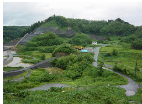
貯水池対策工事
