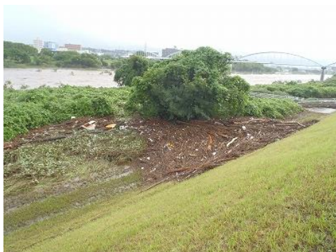
大分川 宮崎樋門（右岸）6k330
