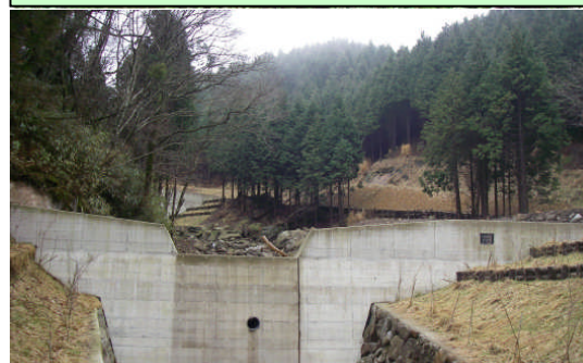
谷が削られないようにしたり土石が流れないようにする谷止工
