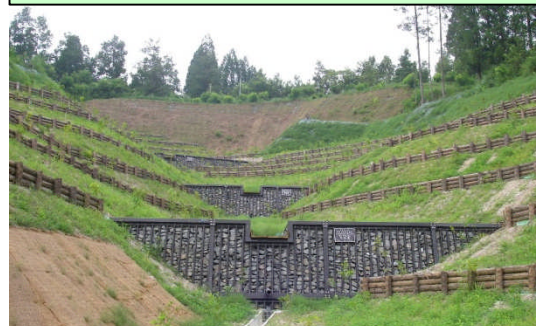
崩れた斜面を森林に戻すための土留工や緑化工(りょくかこう)
