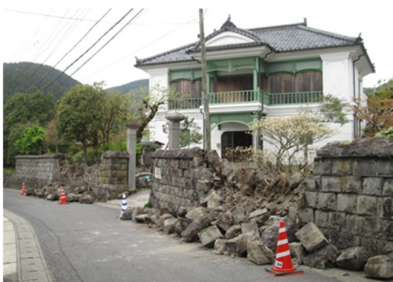
重要文化財 旧日野医院石垣の一部崩落（由布市）
