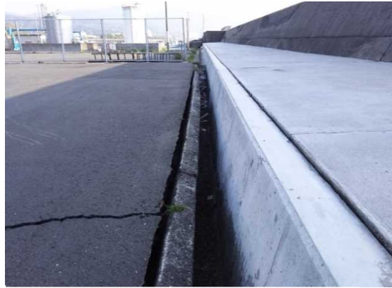
亀川漁港道路擁壁のひび割れ（別府市）
