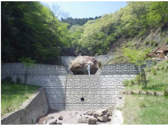
南立石治山ダム被害（別府市）
