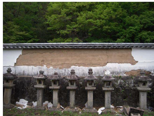
国史跡 中川家墓所碧雲寺の漆喰壁の剥落（竹田市）
