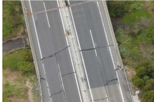
並柳橋の損傷
