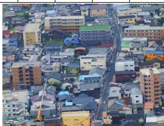
別府市亀川 家屋被害の様子
