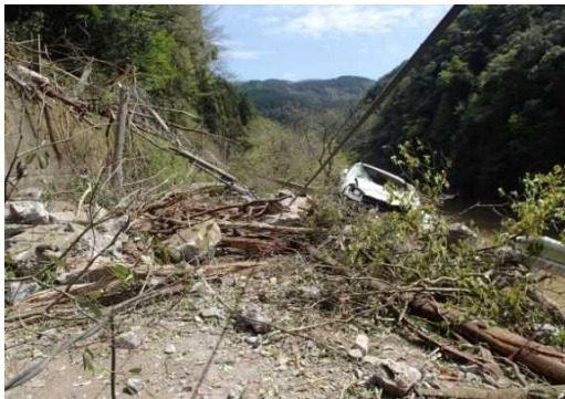
国道 2 1 2 号線被害 (日田市)
