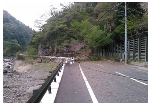
飯田高原中村線の被害 (九重町)
