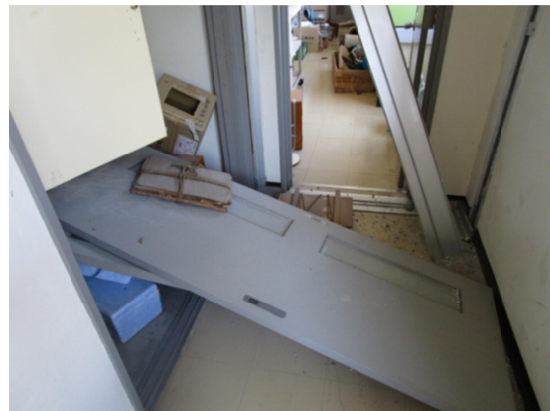
県立由布高校 教室扉破損（由布市）
