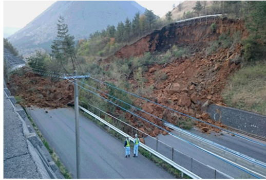
由布岳 P A 付近の崩土
