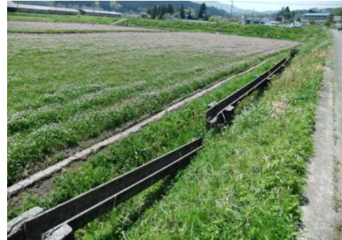
水路の損壊(由布市)
