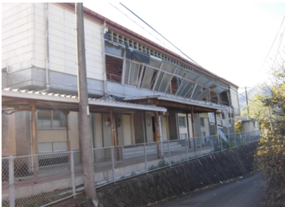
阿南小学校体育館 窓枠破損（由布市）
